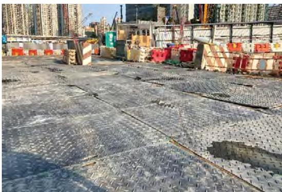
合約編號 HY/2014/20 工地採用高密度聚乙烯（HDPE）塑膠墊鋪設工地路面
