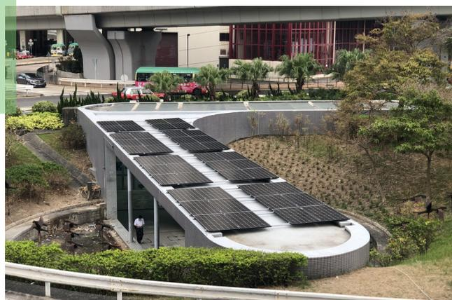
▲ 葵芳現有行人隧道上的光伏發電系統
