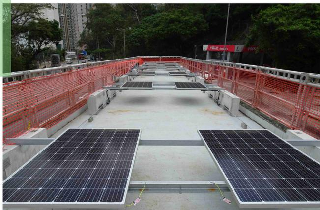
▲ 薄扶林現有行人隧道上的光伏發電系統
