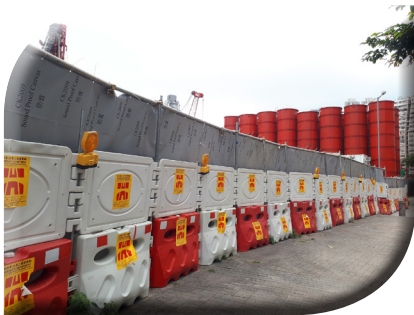
沿工地邊界 豎設隔音屏障
