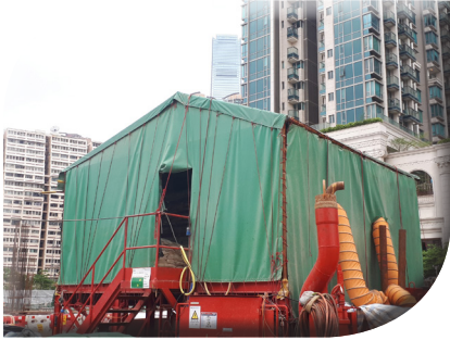
設置全密封式罩以控制 塵土飛揚
