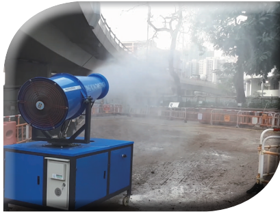
在運料道路使用噴霧 炮機以抑制塵土
