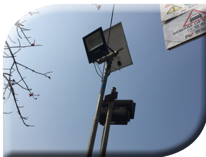
使用可再生能源為工地辦公室、照明系統及滅蚊機供電，節省能源
