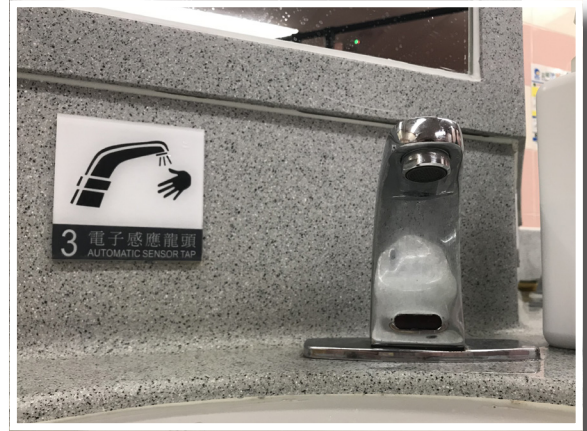
安裝節約用水的流量調節器
