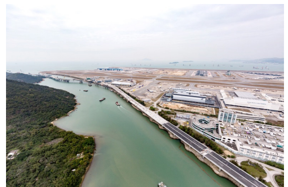
從空中俯瞰機場島南岸的陸上高架橋
