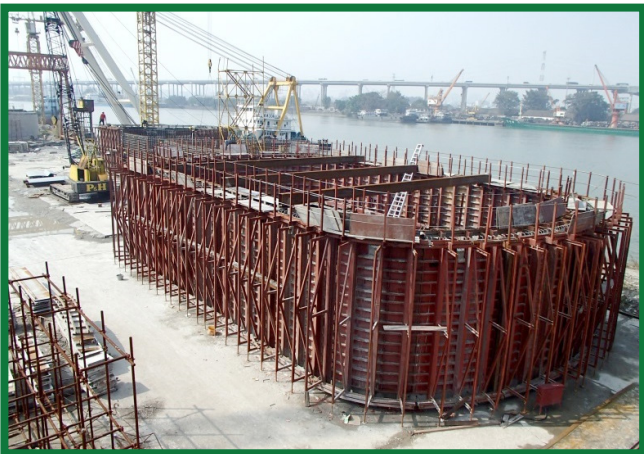
在廣州番禺進行樁帽殼預製工程
