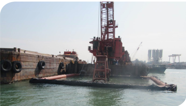
使用籠式隔泥幕緩解對水質的影響
