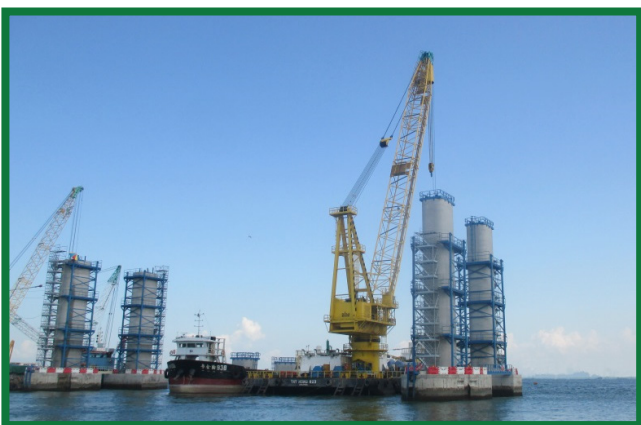
在香港西部水域建造橋墩
