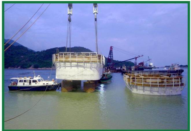
在機場水道安裝樁帽殼預製件
