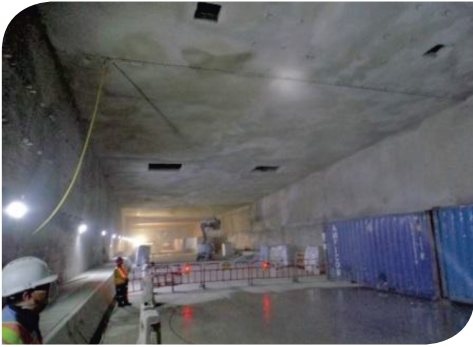
在噴塗熱障時採用水簾系統防止塵土飄出隧道外
