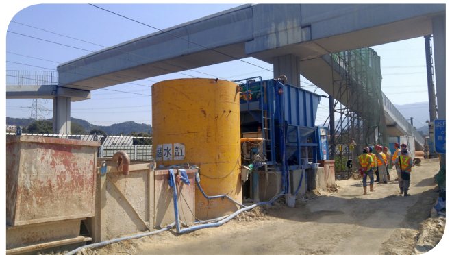
排放廢水前，先在現場進行處理
