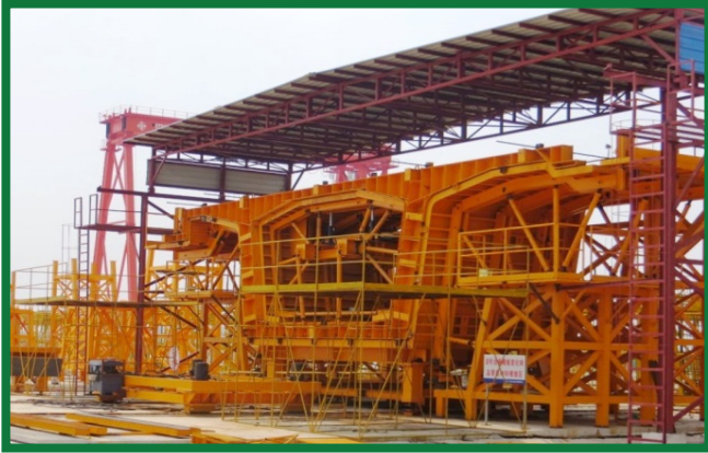
在中山組裝橋面組件的預製模具
