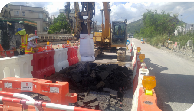
用吸音物料包裹碎石機
