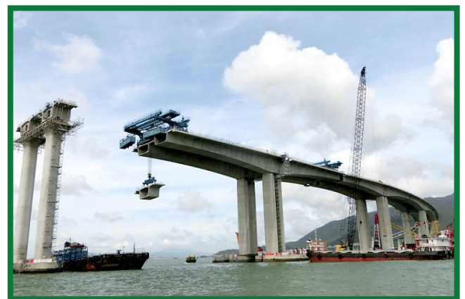
在香港西部水域安裝橋面預製件
