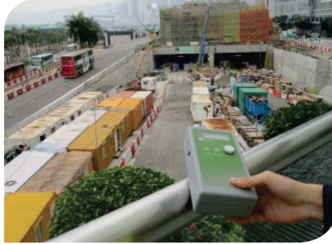
監察工地的懸浮粒子含量
