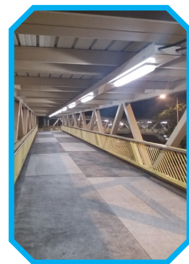
在行人天橋採用 發光二極管燈及智慧調暗系統
