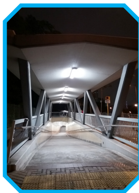
在行人隧道 以發光二極管光管取代T8螢光管
