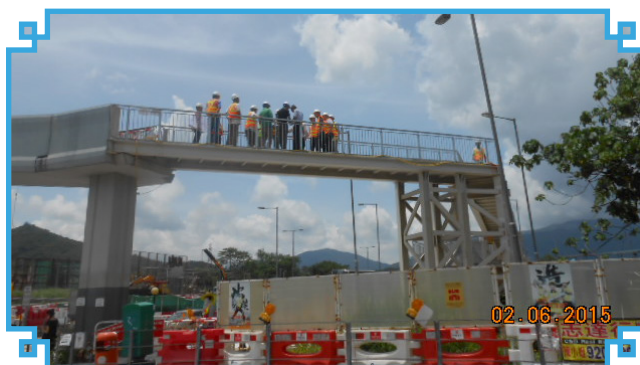
大埔區議會工作小組參觀吐露港公路工地
