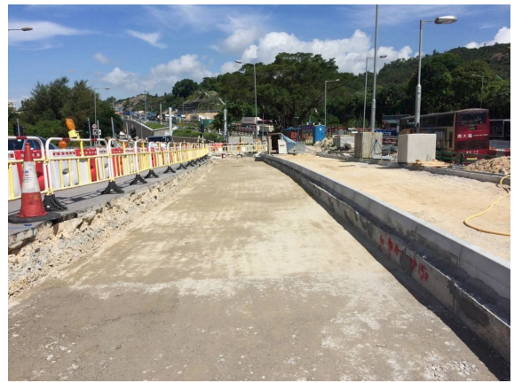
壓實後的循環再造石料表面
