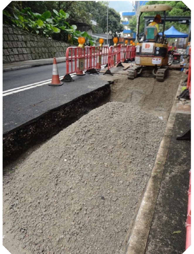
在試驗地點鋪砌循環再造石料作為底基層
