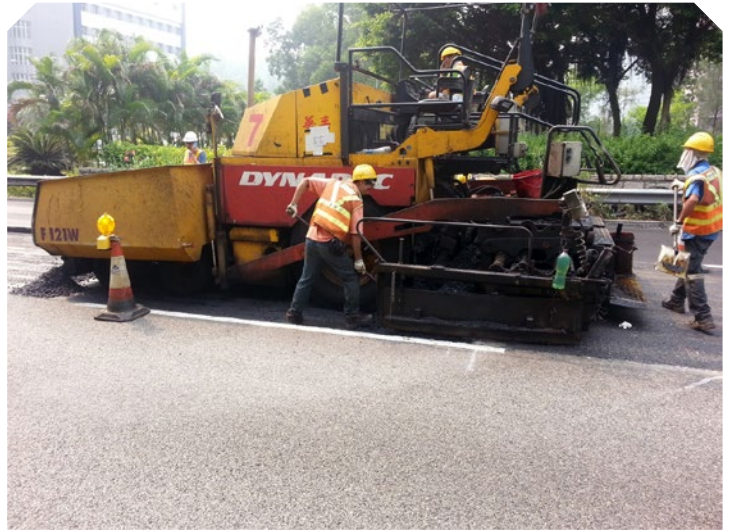
東涌裕東路的道路重鋪工程
