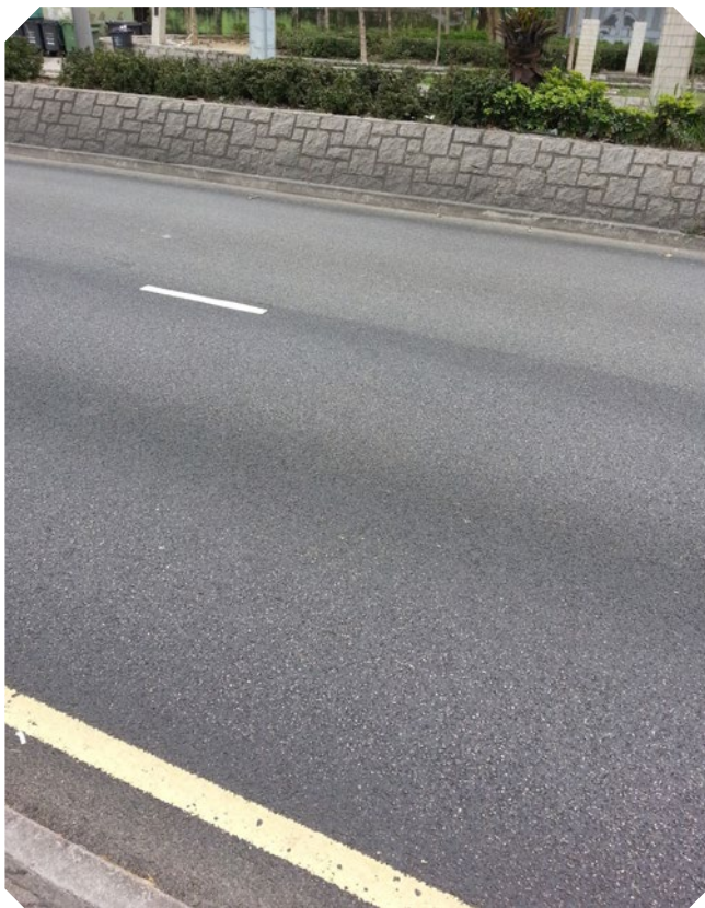
沙頭角公路用聚合物改性瀝青瑪蹄脂碎石混合物鋪砌的路面
