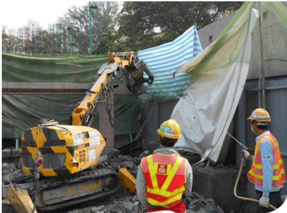
採用寧靜的機械(液壓軋碎機)拆卸涼亭
