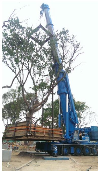
採用可提舉500噸重物的流動起重機移植樹木，並以特製鋼箱裝載進行移植的根球。
