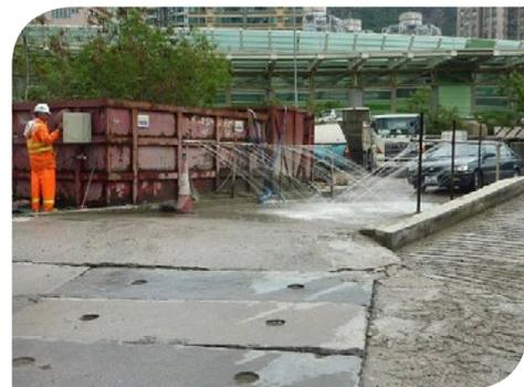
在工地出入口設置車輪沖洗設施
