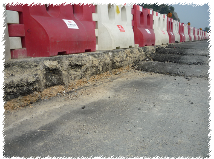
施工中的瀝青路底
