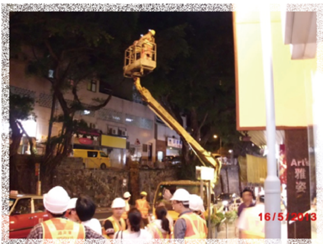
路政署的專業人員在施工期間進行現場監督
