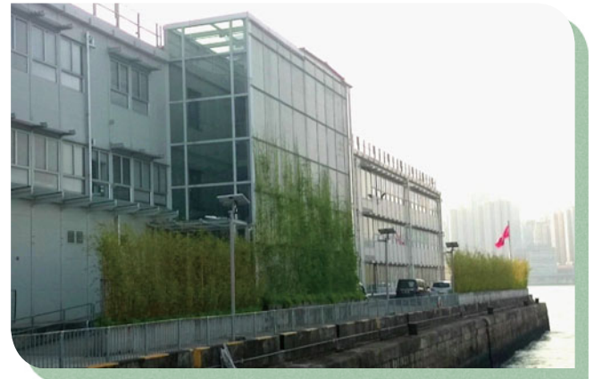
紅磡工地辦公室的一排排竹樹和玻璃幕牆
