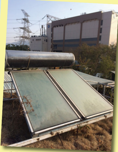
為停車場照明供電的太陽能電池板
