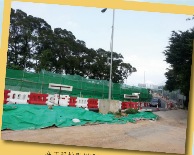
在工程地點周邊設置隔塵網
