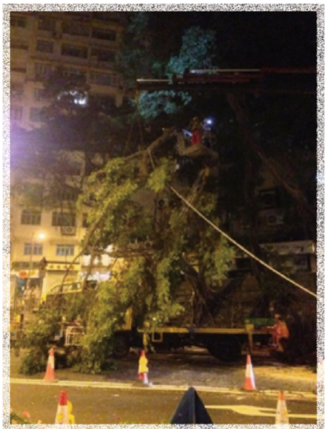
吊臂貨車把剪除的樹枝運往地面清理
