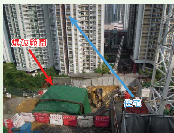
明山爆破以建造黃竹坑車廠及海怡半島通風及機房大樓
