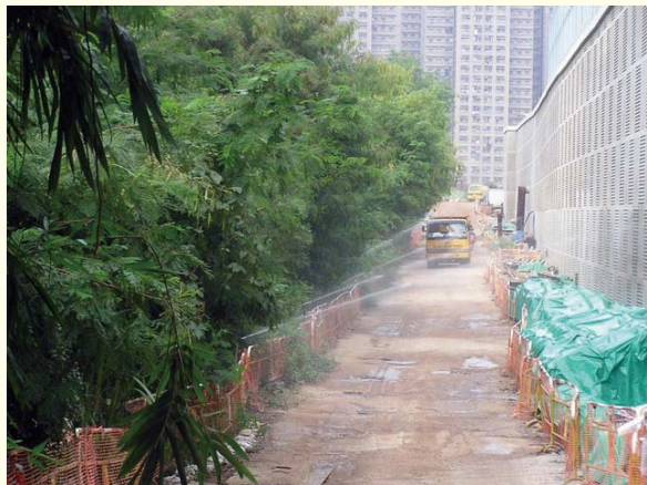
在工地通道安裝灑水系統
