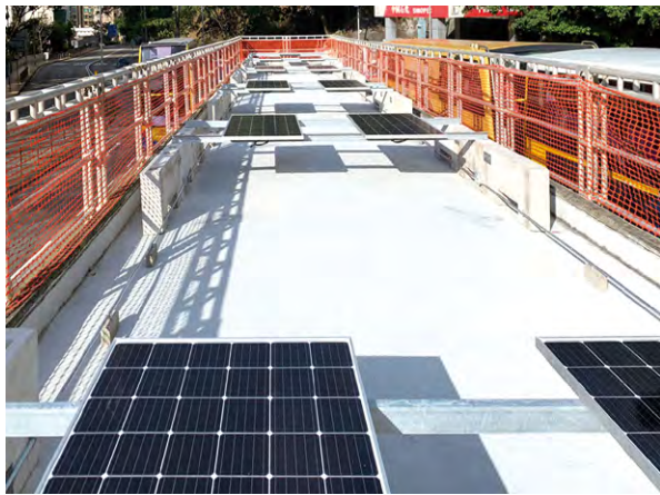
位於薄扶林道近蒲飛路的行人隧道 (於二零二零年完成)
