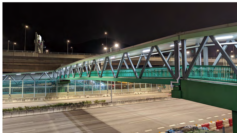
裝設有 LED 燈的行人天橋
