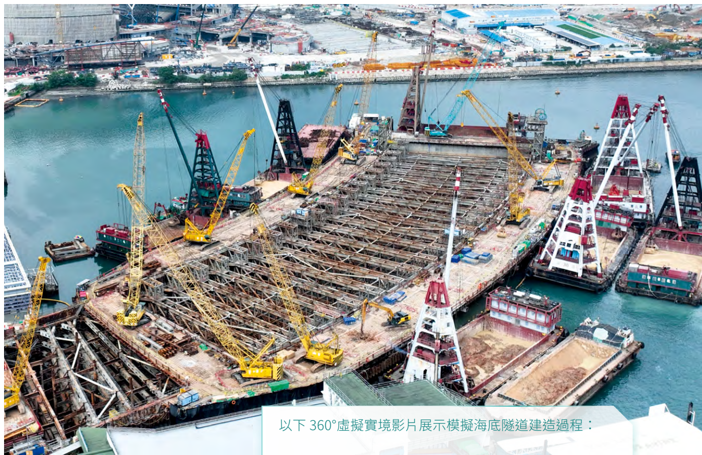
位於九龍灣建造中的海底隧道
