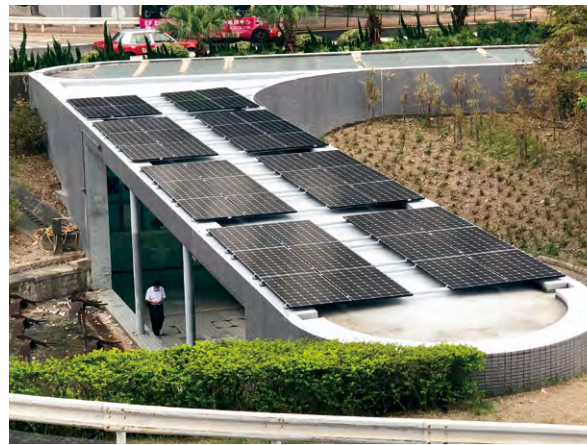
位於葵福路近葵芳站的行人隧道 (於二零二一年完成)
