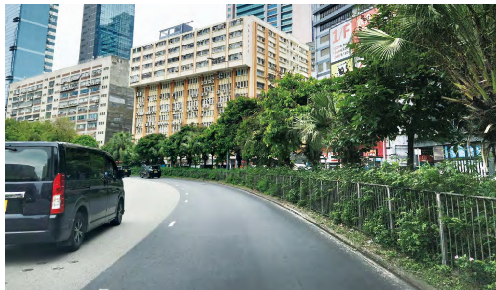
鋪設在長沙灣道的橡膠瀝青路面物料
