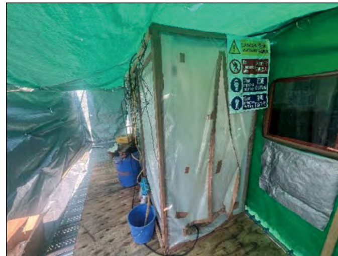
三進除污室 3-chamber decontamination unit
