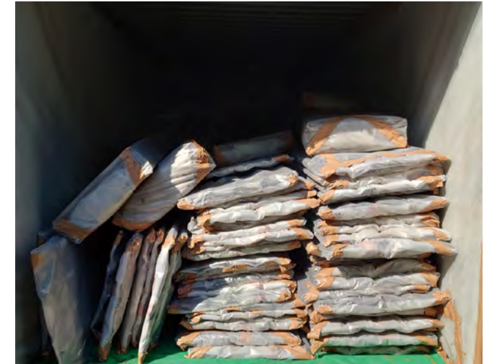
石棉廢物存放於指定的臨時存放區 Asbestos wastes inside temporary storage
