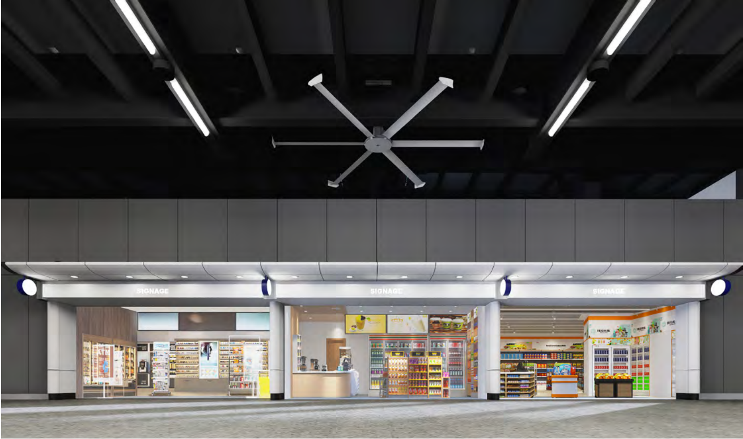
位於大堂範圍的大風量低轉速風扇 High-Volume Low-Speed fans in concourse area
