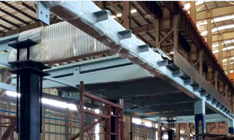
「7」字形預製組件 "7"-shaped pre-fabricated modules
