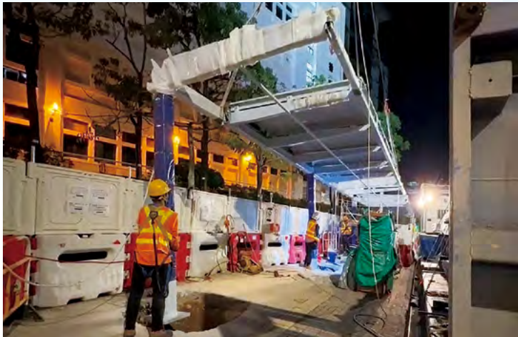
在工地現場安裝預製組件 Installation of prefabricated modules on-site
