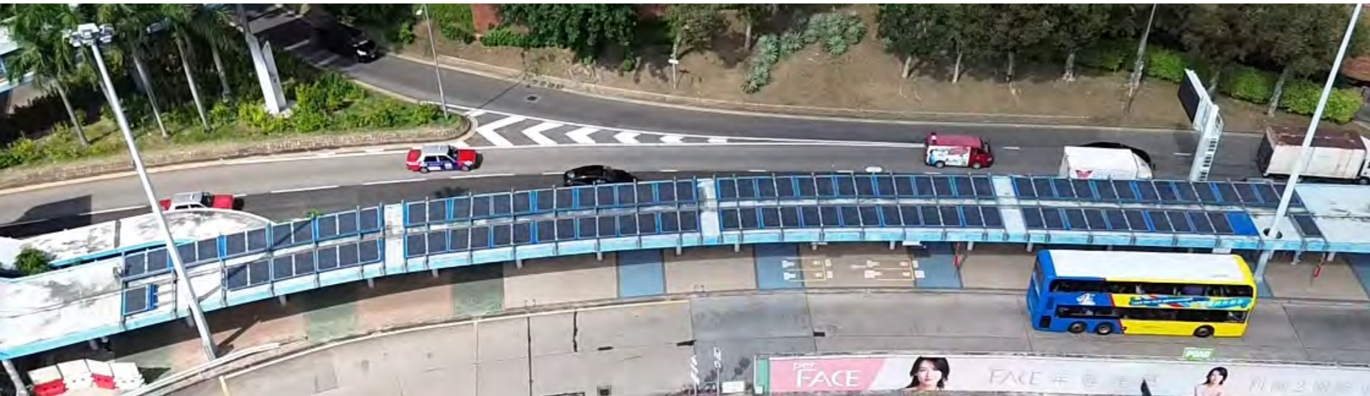
在康莊道鄰近香港理工大學的有蓋行人道的光伏發電系統
