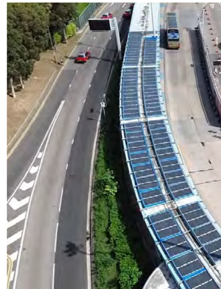
在康莊道鄰近香港理工大學的有蓋行人道的光伏發電系統
