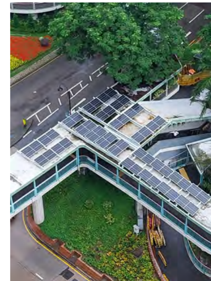
在漆咸道南鄰近香港科學館的行人天橋的光伏發電系統
