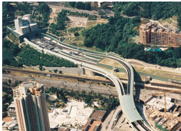
沙田嶺隧道 Shatin Heights Tunnel
