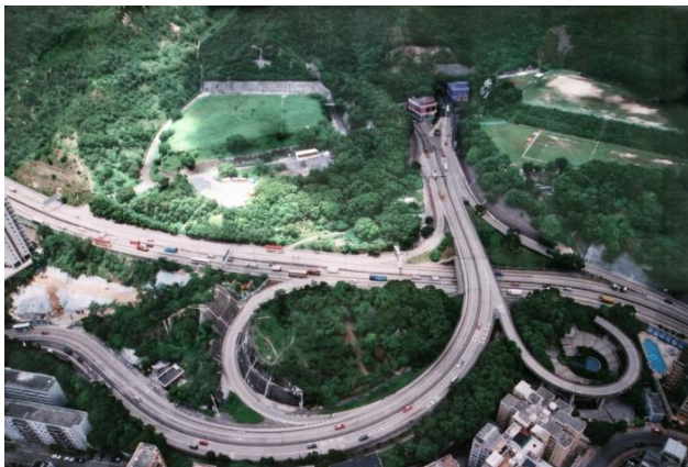
獅子山隧道 Lion Rock Tunnel
