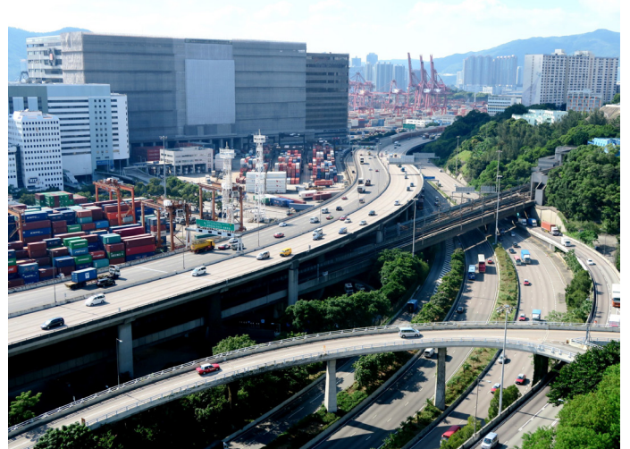
葵涌高架道路
