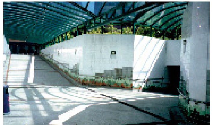
位於跑馬地穿過體育路的行人隧道
