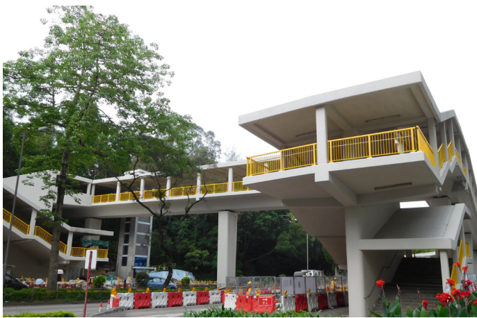
在橫跨汀角路的行人天橋增設無障礙設施
