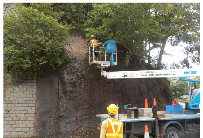
清理路旁斜坡上的排水孔及修補斜坡護面的裂痕
