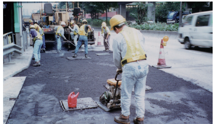
在快速道路上鋪設承重層 Laying of base course on in High Speed Road
