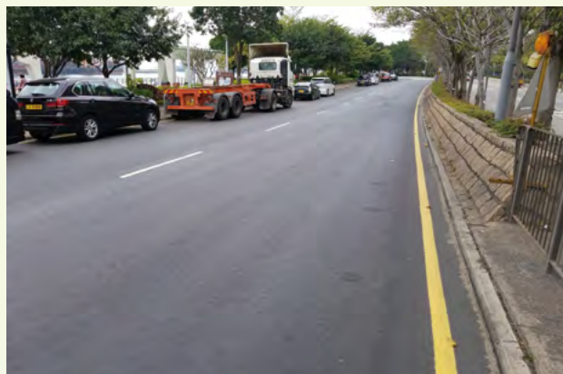
鋪設在海輝道的橡膠瀝青路面物料
