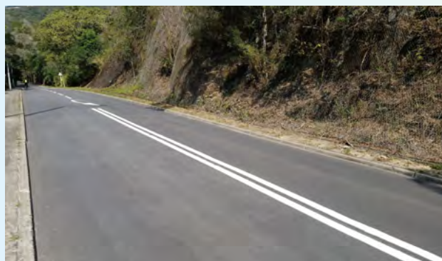
鋪設在新娘潭路的橡膠瀝青路面物料
