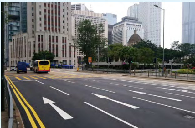
鋪設在金鐘道的 PMSMA6 物料
