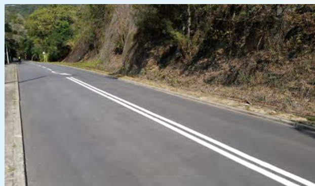
鋪設在新娘潭路的橡膠瀝青路面物料
