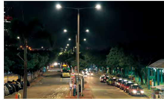
裝設 LED 燈的公共道路
