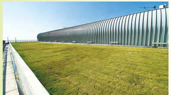
位於北面通風大樓的綠化天台
