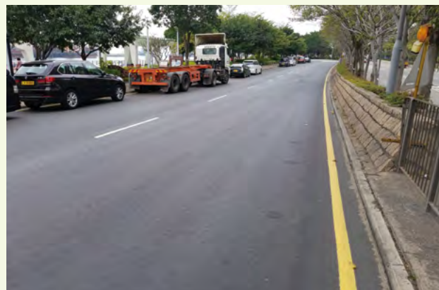
鋪設在海輝道的橡膠瀝青路面物料
