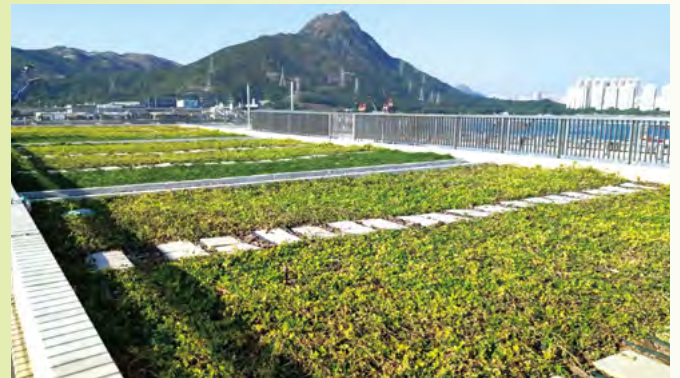
位於海關屯門船隊基地的綠化天台
