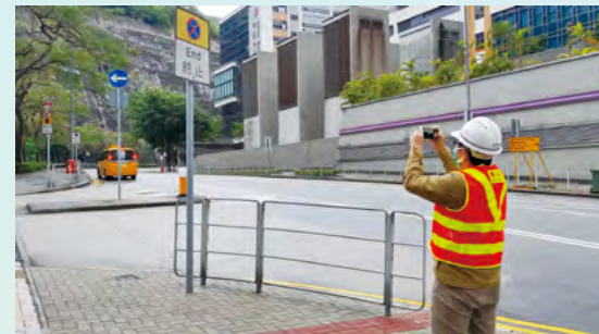
工程師視察 - 交通標誌
