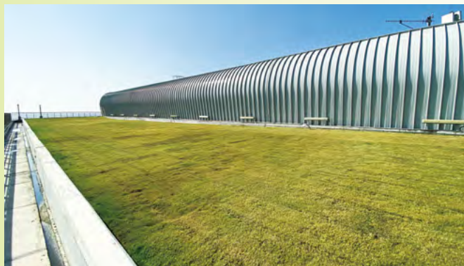
位於北面通風大樓的綠化天台
