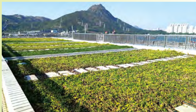
位於海關屯門船隊基地的綠化天台
