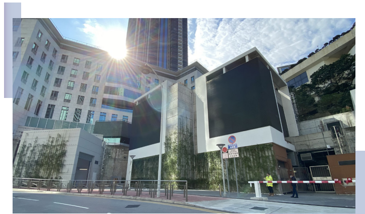
▲ 在香港公園通風大樓種植垂直攀緣植物
