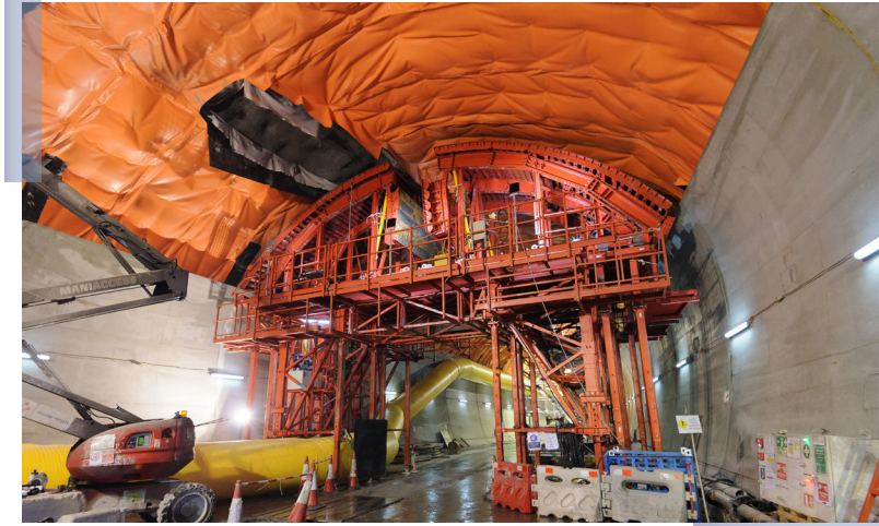
◀ 移動式隧道壁襯砌鋼模
