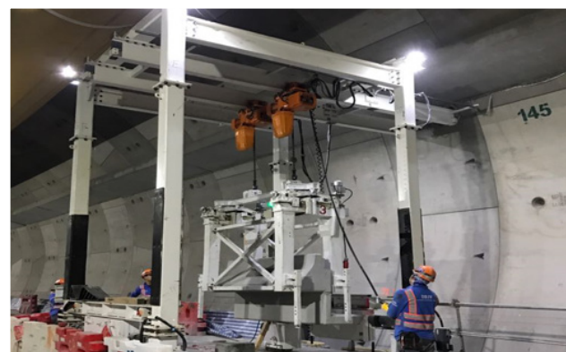
安裝預製護欄
