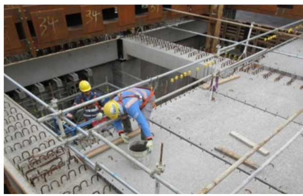
安裝預製面板
