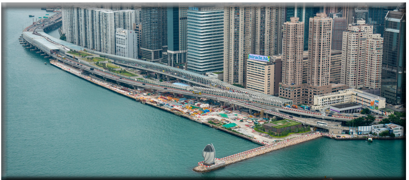
東區走廊連接路的隔音罩及隔音屏障
