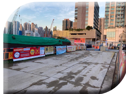
使用混凝土板作 車輛通道以抑制塵土
