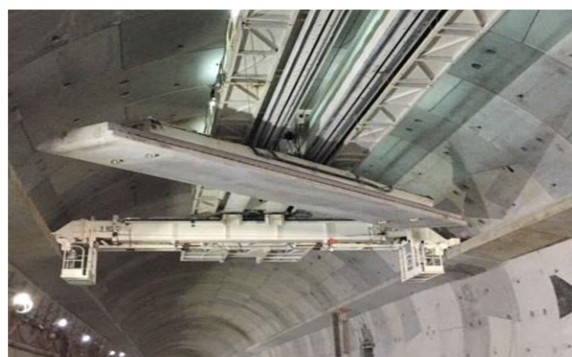
安裝架空通風管道面板
