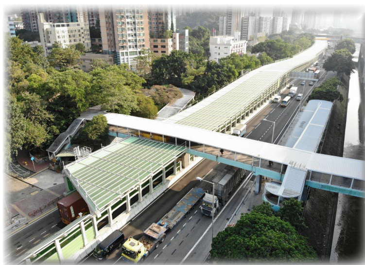
屯門公路(虎地段)的隔音屏障及隔音罩
