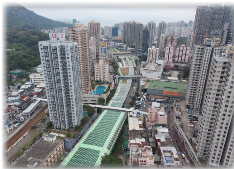
屯門公路(市中心段)的隔音屏障及隔音罩
