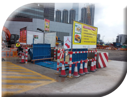
在工地出入口提供車輪沖洗機
