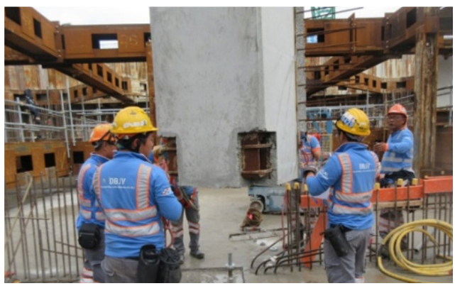
安裝預製支柱
