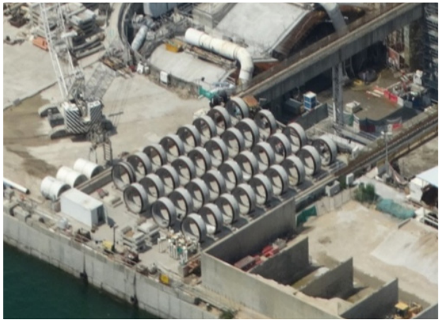
連接通道的預製頂管
