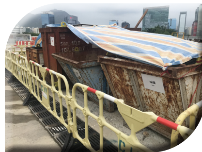
回收打樁工程的廢棄金屬
