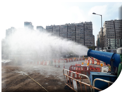
在運料通路使用 噴霧炮機以抑制塵土
