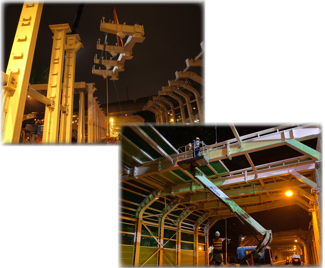
在晚間裝置鋼結構及安裝隔音板
