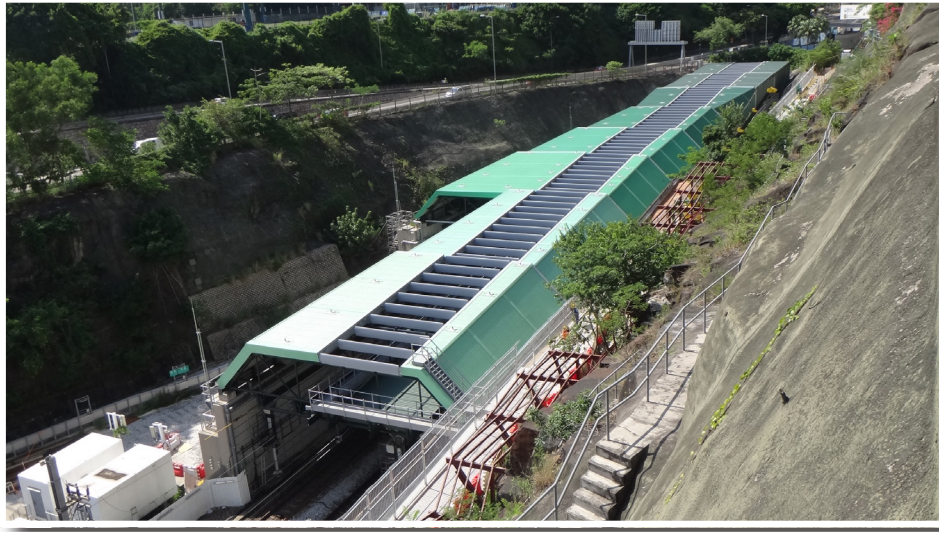
位於愛民邨附近1A隧道入口已落成的隔音罩
