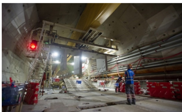
安裝公用設施通道
