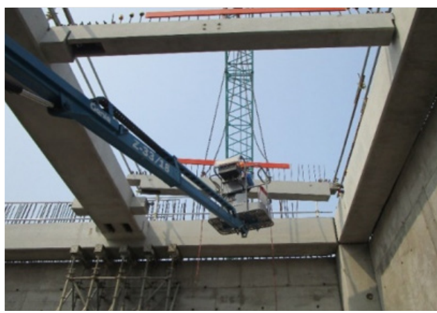
安裝預製橫樑
