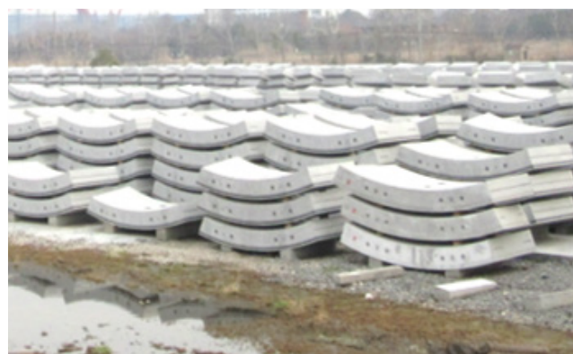
隧道襯砌組件 (配合隧道鑽挖機使用)
