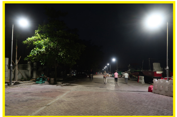
坪洲—更換為LED燈後
