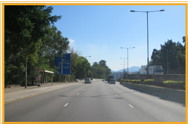
鋪設於沙田火炭路的橡膠瀝青
