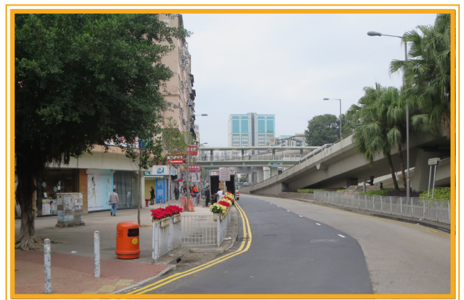
鋪設於元朗安樂路慢線的橡膠瀝青
