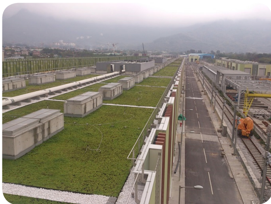
石崗列車維修庫的綠化屋頂
