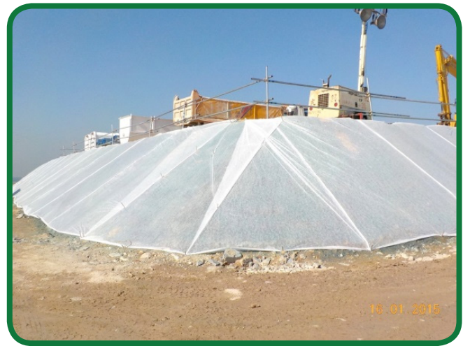
消減空氣污染措施 - 為斜坡噴草，防止塵土擴散
