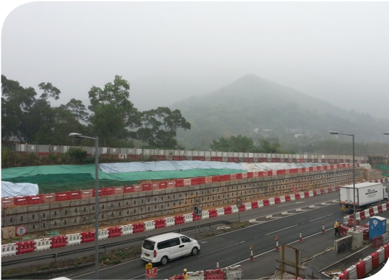
覆蓋光禿的斜坡防止塵土揚起
