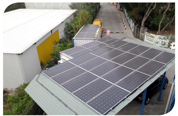
在工地辦公室安裝太陽能電池板
