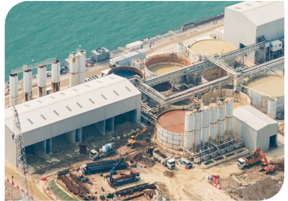
循環再用 / 重用隧道鑽挖機的泥頭
