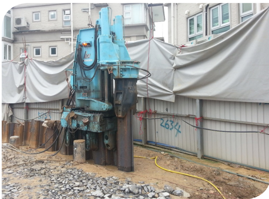
採用靜音式打樁機 以減低噪音及振動
