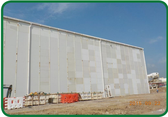
噪音緩解措施 - 在泥漿處理廠安裝隔音罩
