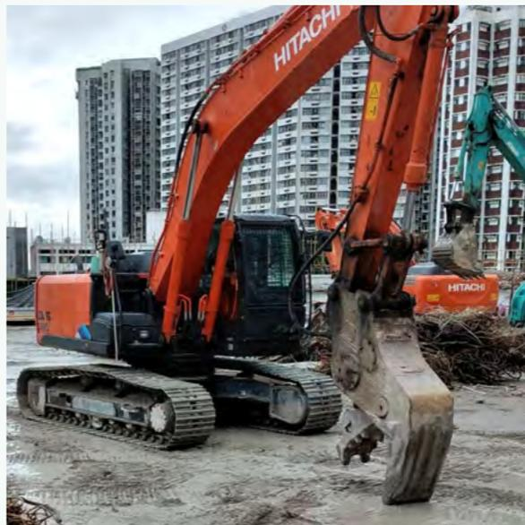
裝設在挖掘機上的液壓碎石機
