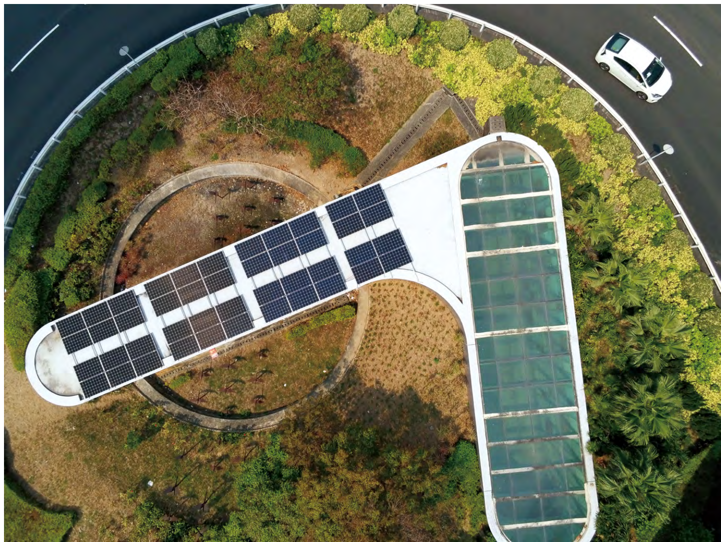
在葵福路現有行人隧道頂部的光伏發電系統
