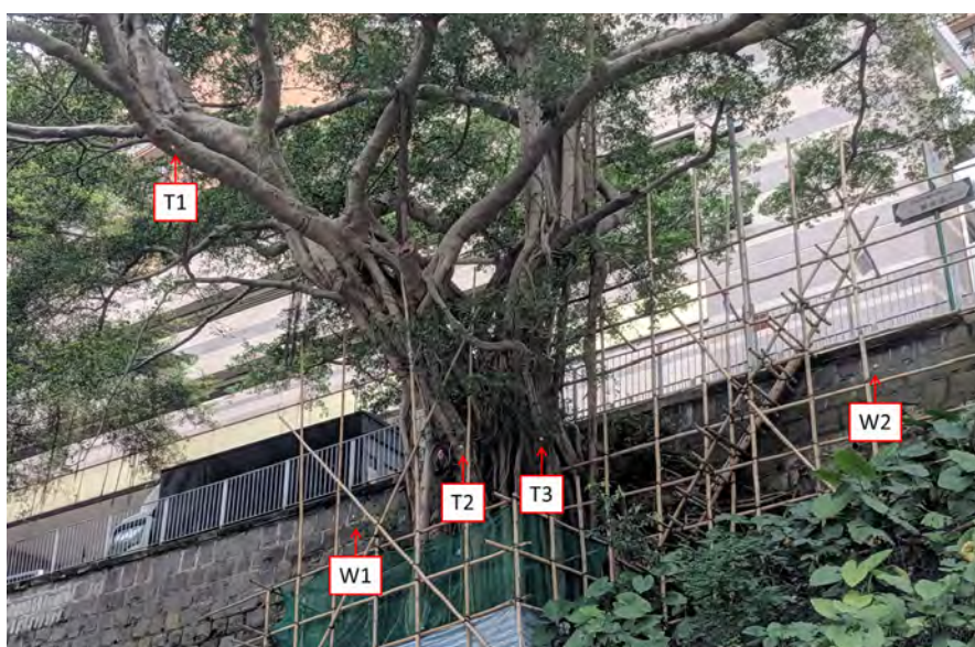
■ 石牆和石牆樹上的特定測點位置
