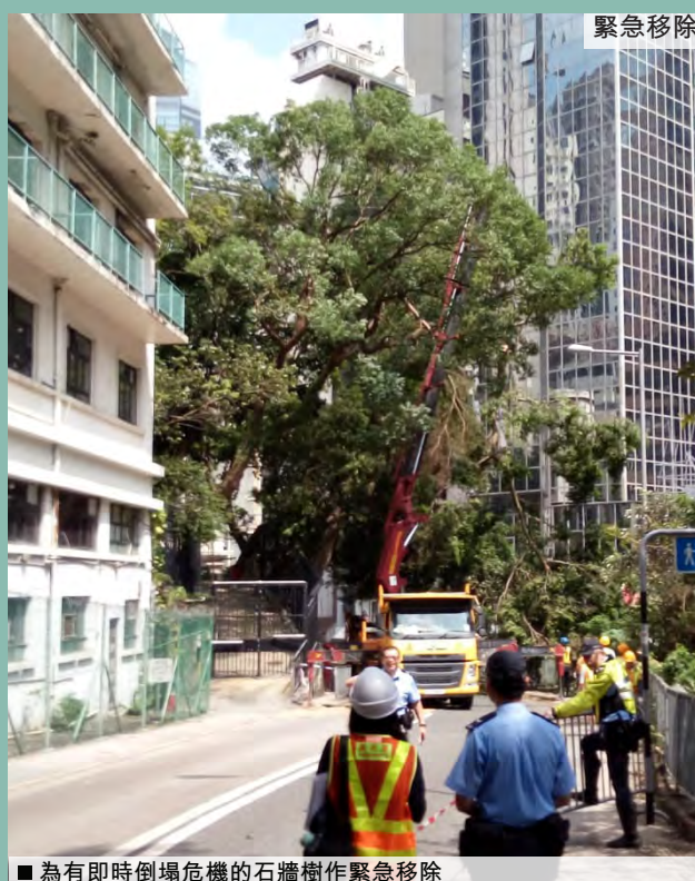
■ 為有即時倒塌危機的石牆樹作緊急移除
