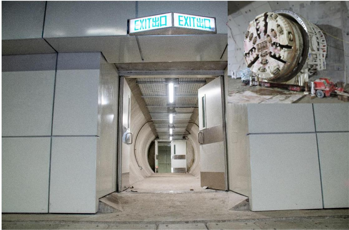
小型隧道鑽挖機貫通跨管通道
