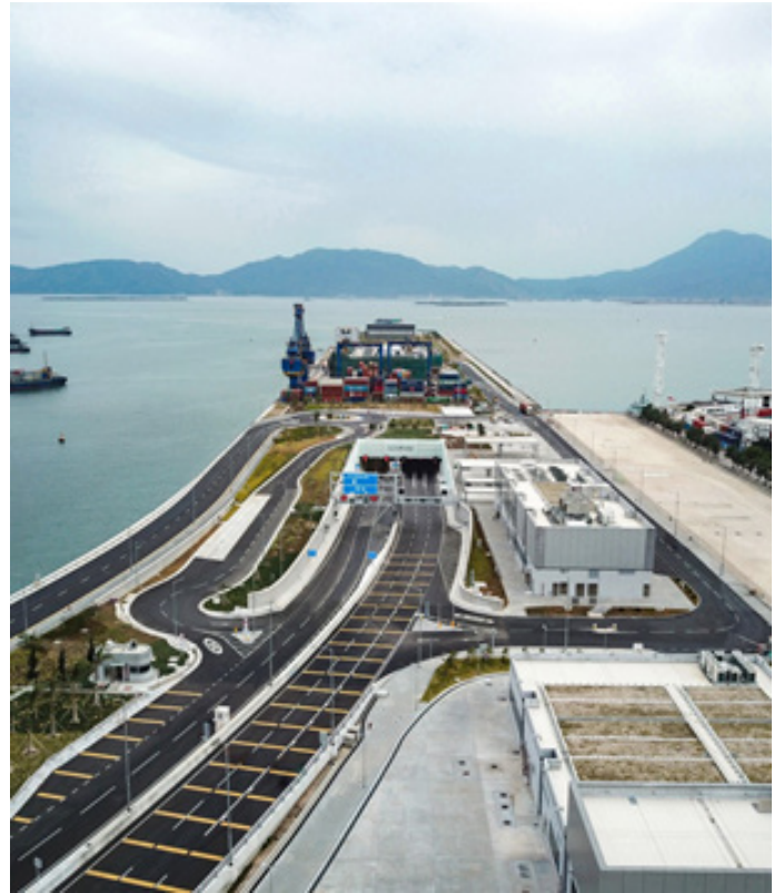
北面隧道出入口
