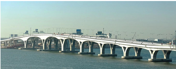
南面连接路及北大屿山公路 - 海上高架桥的桥墩呈英文字母「Y」形，仿似海鸥展翅飞翔，遨游水道。
