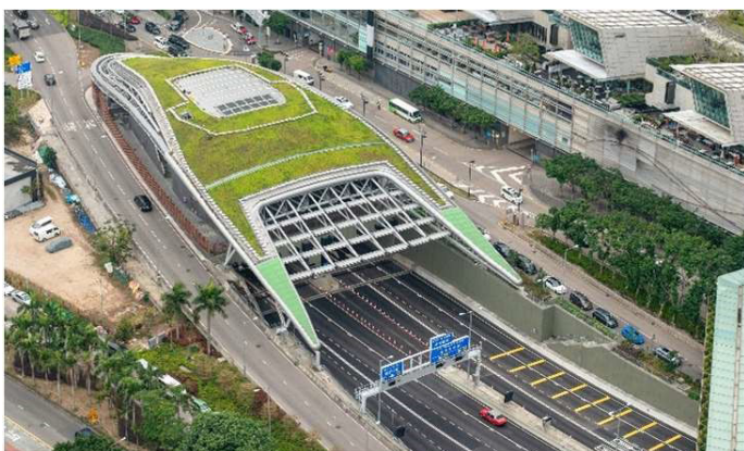
中环隧道出入口 / 西面通风大楼
