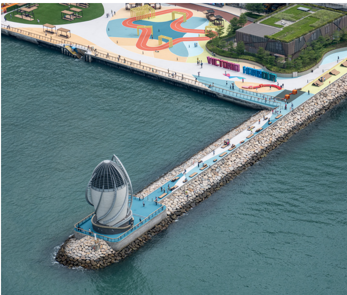
位于铜锣湾避风塘东防波堤旁的东面排风口
