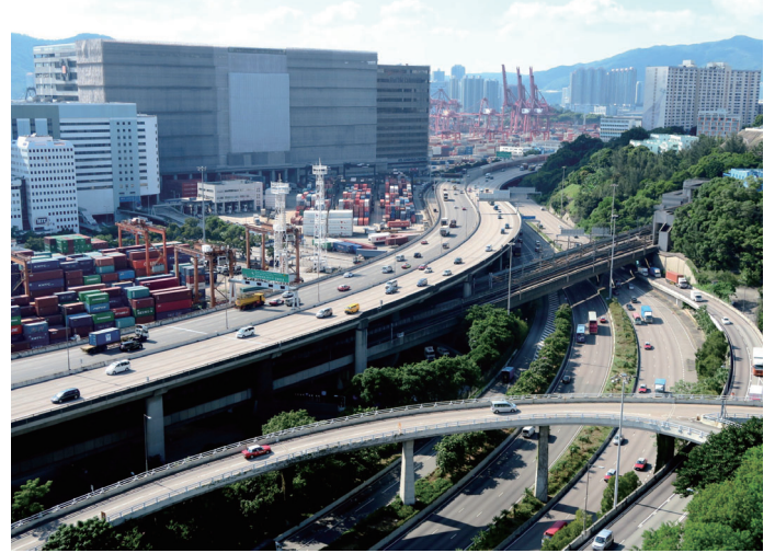
葵涌高架道路
