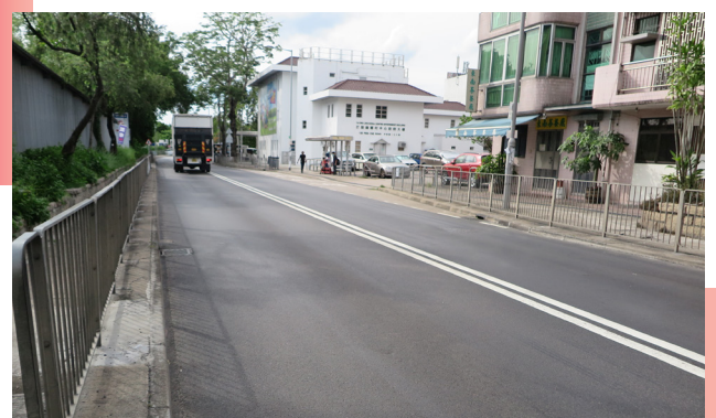
PMSMA6 laid at Peng Che Road ▶
