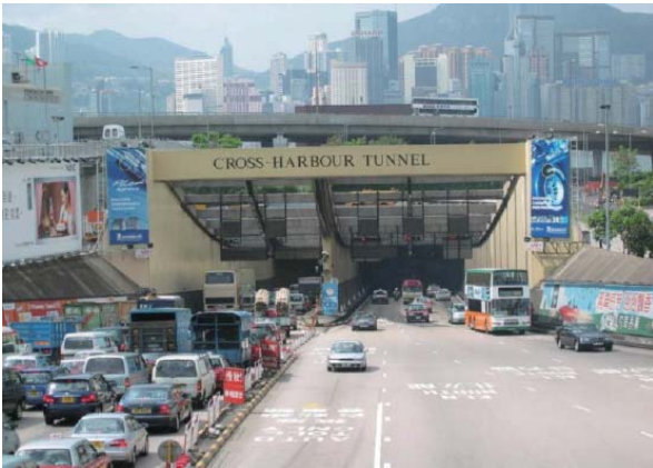
海底隧道 Cross-Harbour Tunnel
