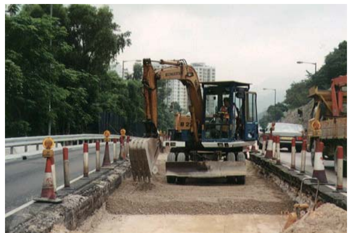
重鋪道路 Road reconstruction
