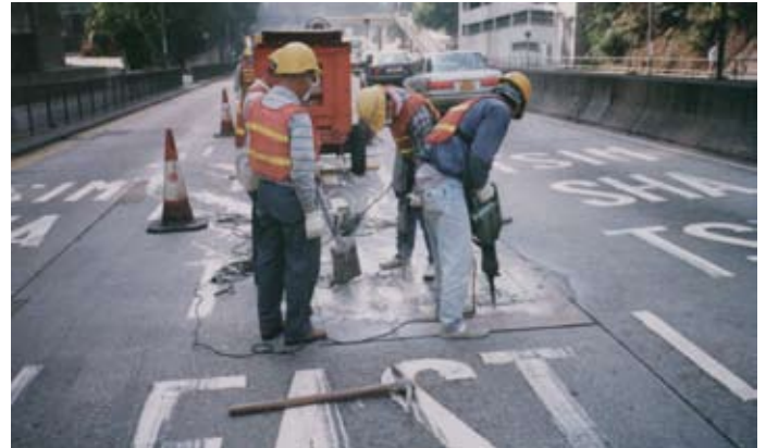
在快速道路進行維修工程 Preparation work on High Speed Road
