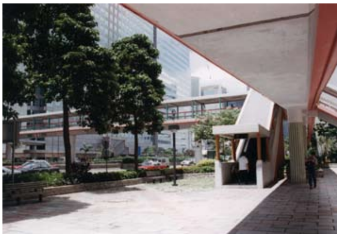
位於分域街橫跨告士打道的行人天橋
