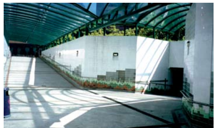
位於跑馬地穿過體育路的行人隧道
