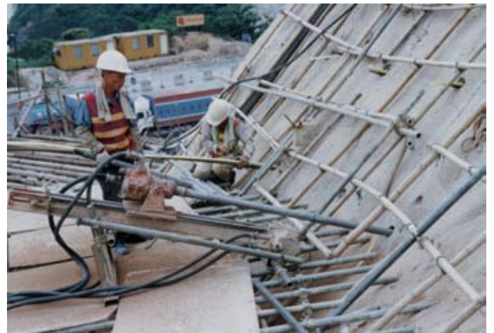
斜坡改善工程：打泥釘
