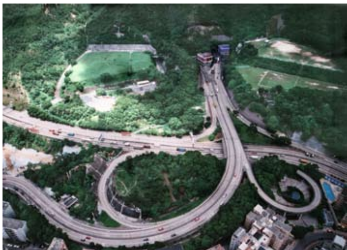
獅子山隧道 Lion Rock Tunnel
