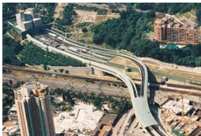
沙田嶺隧道 Shatin Heights Tunnel
