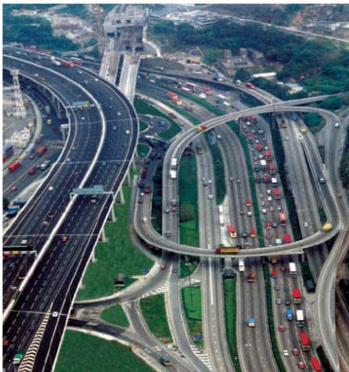
葵涌高架道路
