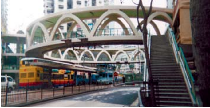
位於銅鑼灣橫跨怡和街的行人天橋
