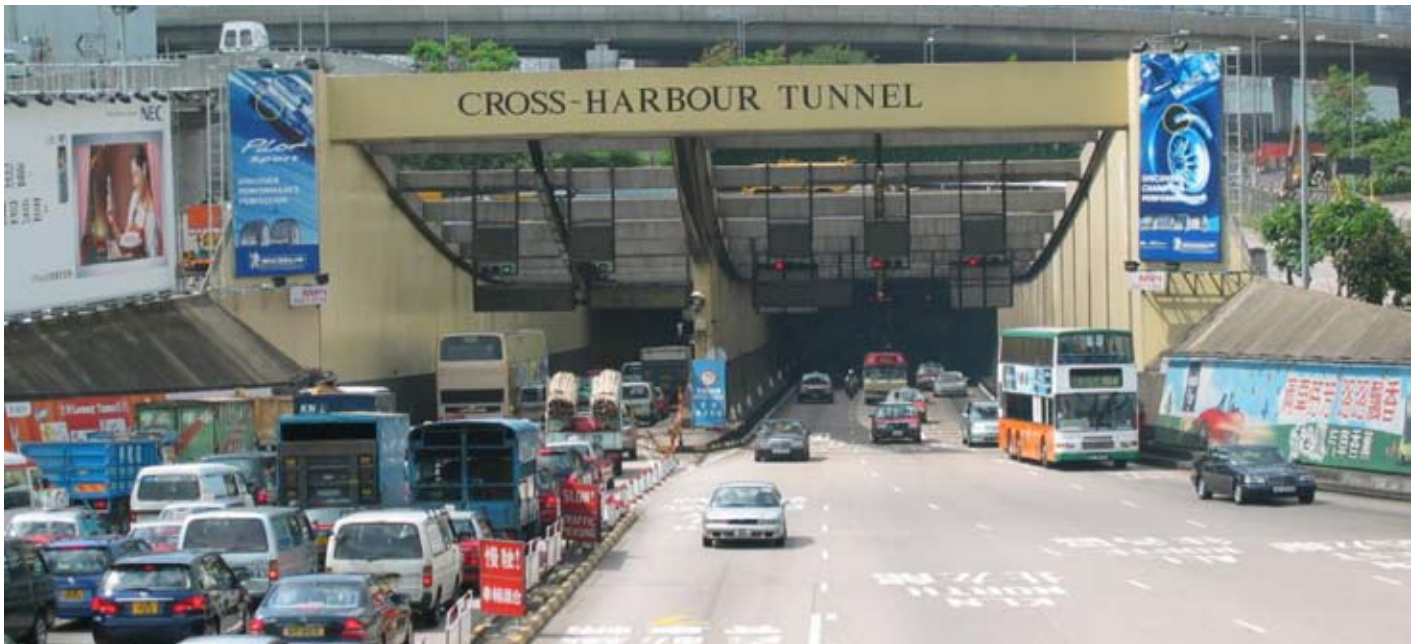
海底隧道 Cross Harbour Tunnel
