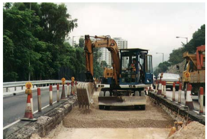
重鋪道路 Road reconstruction
